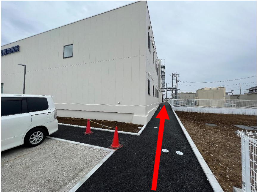
④建物北側 歩行通路
